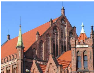
Elewacja pn.-wsch. stan przed
